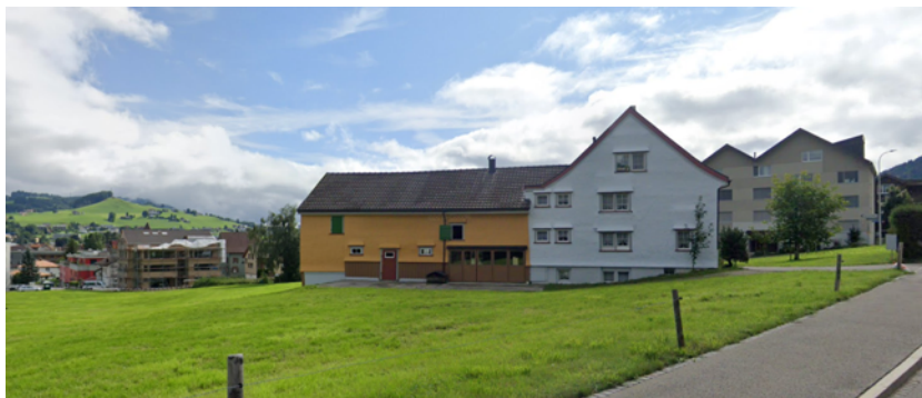
Abb. 32 Beispiel einer an die Siedlung angrenzenden Stammliegenschaft entlang der Kaustrasse, StreetView (August 2019)
